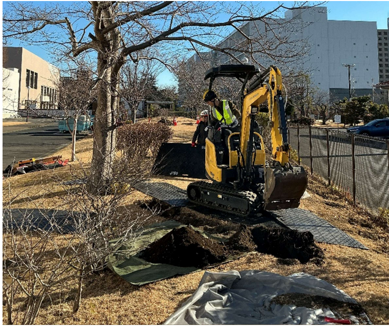
バックホウによる土壌掘削
