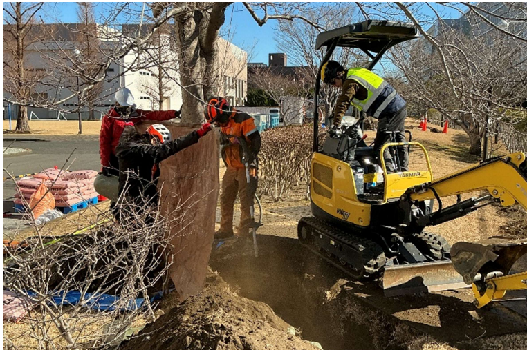
エアースコップによる土壌掘削
